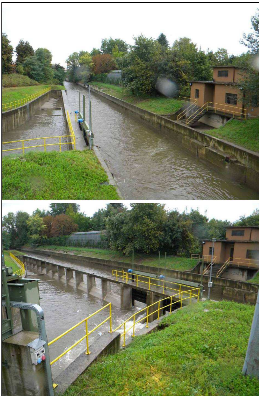
Figura 17 – Opera di presa C.S.N.O. vista da valle
